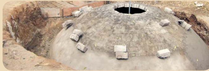
... und Fertigstellung der Biogasanlage in Bura.
